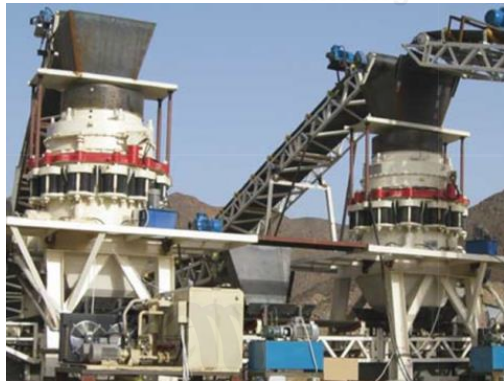
Base estructuras para chancadoras
