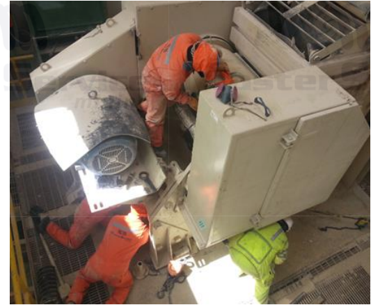
Montaje de chancadoras
