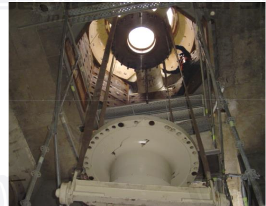
Asistencia y Montaje de chancadoras primarias
