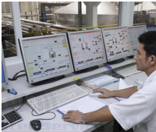
Instalación de instrumentos y pruebas de funcionamiento
